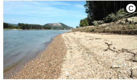
Uferrückbau 1,4 km Abtrag der Steinsicherungen
