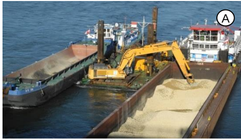
Sohlanpassung u. Granulometrische Sohlverbesserung – Erprobung der Einbaumethode – rd 130.000 m³ Kies
