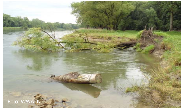
Entfernung der Uferversteinung lässt Seitenerosion zu (Donau zwischen Vohburg und Neustadt)
