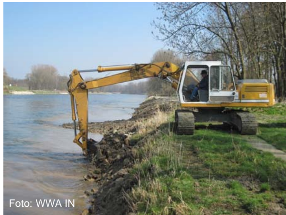
Entfernung der Uferversteinung lässt Seitenerosion zu (Donau zwischen Vohburg und Neustadt)
